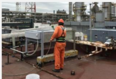
Rehabilitación de aire acondicionado
