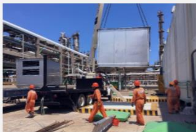
Suministro e instalación de sistemas de ambientación
