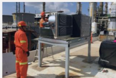
Servicio de rehabilitación a sistema de presurización
