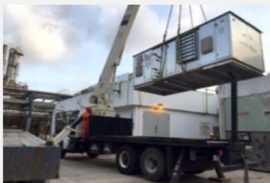
Suministro e instalación de sistemas de ambientación
